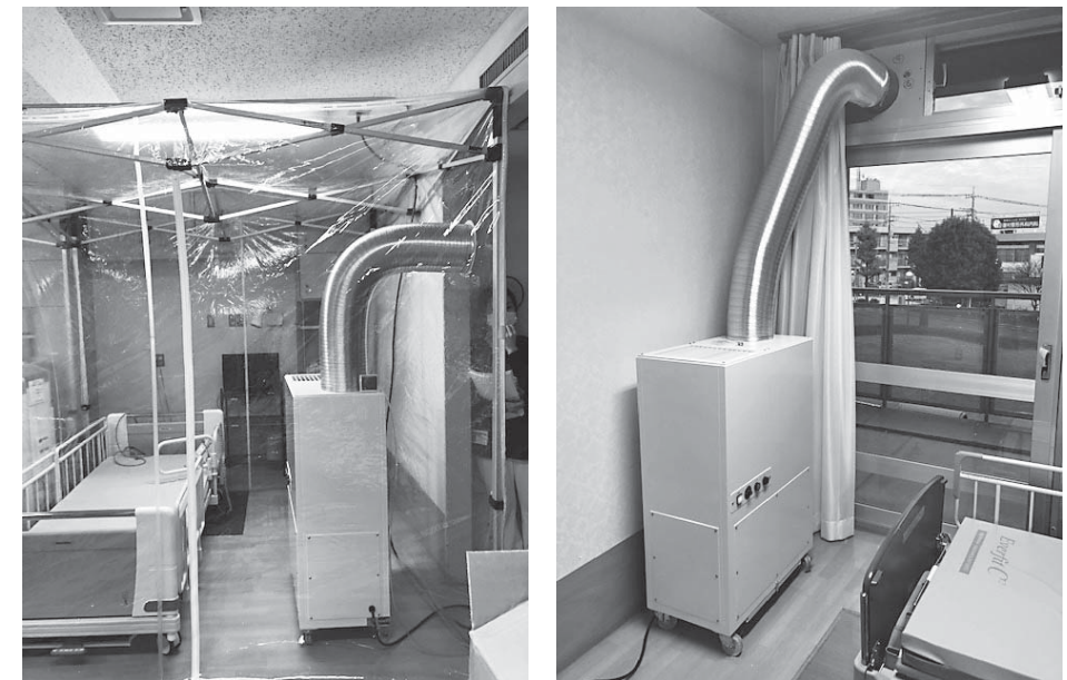
図3 陰圧室をつくる機械
